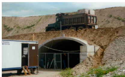
Prova di sollecitazione di una struttura BEBO, "Large Span Culvert Field Test program" Università di Massachusetts (Stati Uniti), 1997.
