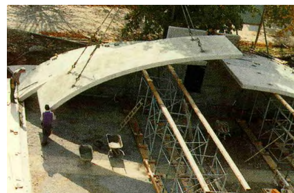
Autorimessa interrata prefabbricata BEBO, ad arco ribassato e senza colonne. Fase di montaggio in Germania.
