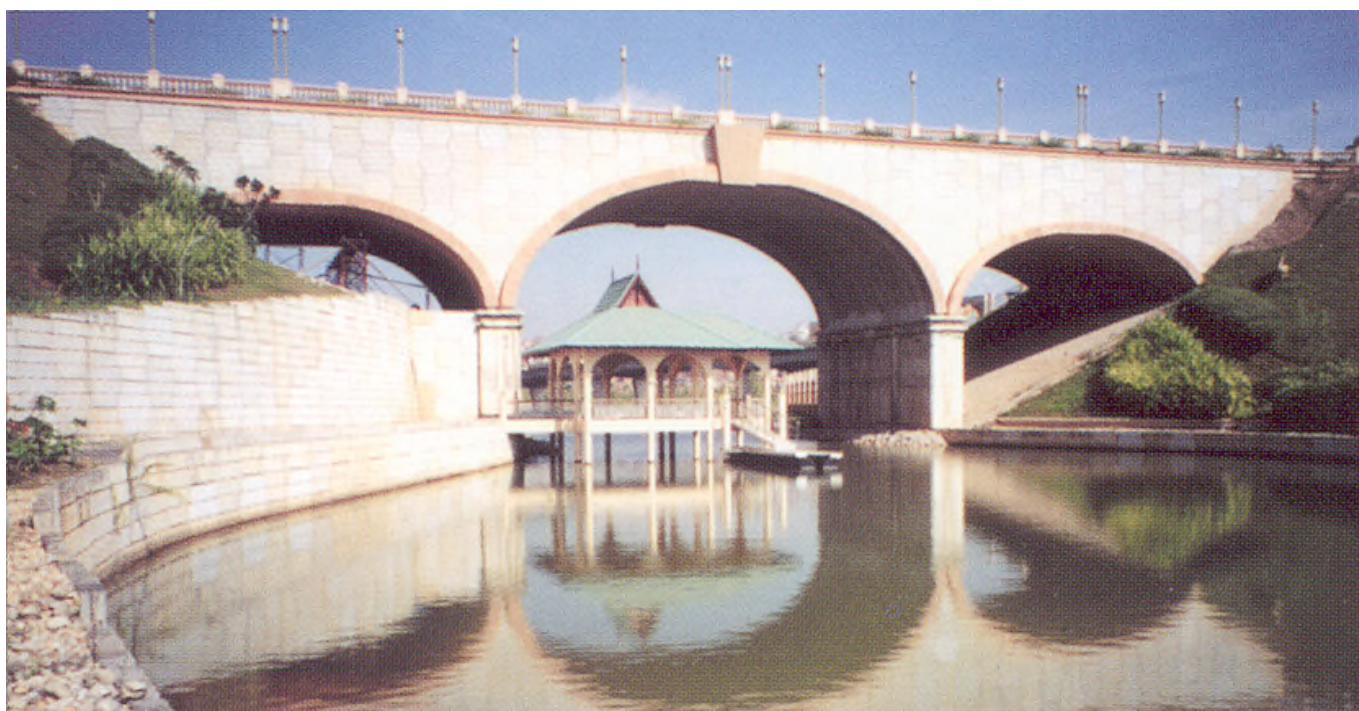
Ponte ad arco prefabbricato e coperto più lungo del mondo (25 metri di campata BEBO) a Putrajaya Malaysia.
