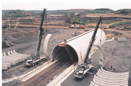
Una galleria ferroviaria BEBO, progettata per sostenere altissime coperture e carichi da camion minatori fino a 500 tonnellate.
