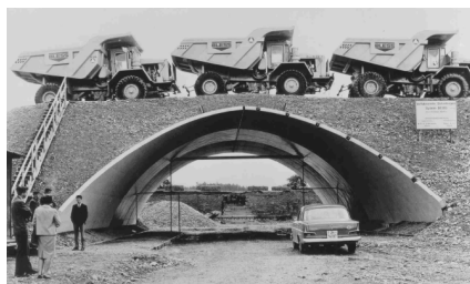
Il prototipo BEBO con uno spessore di 160 mm ha dimostrato l'estrema portata delle strutture BEBO.
