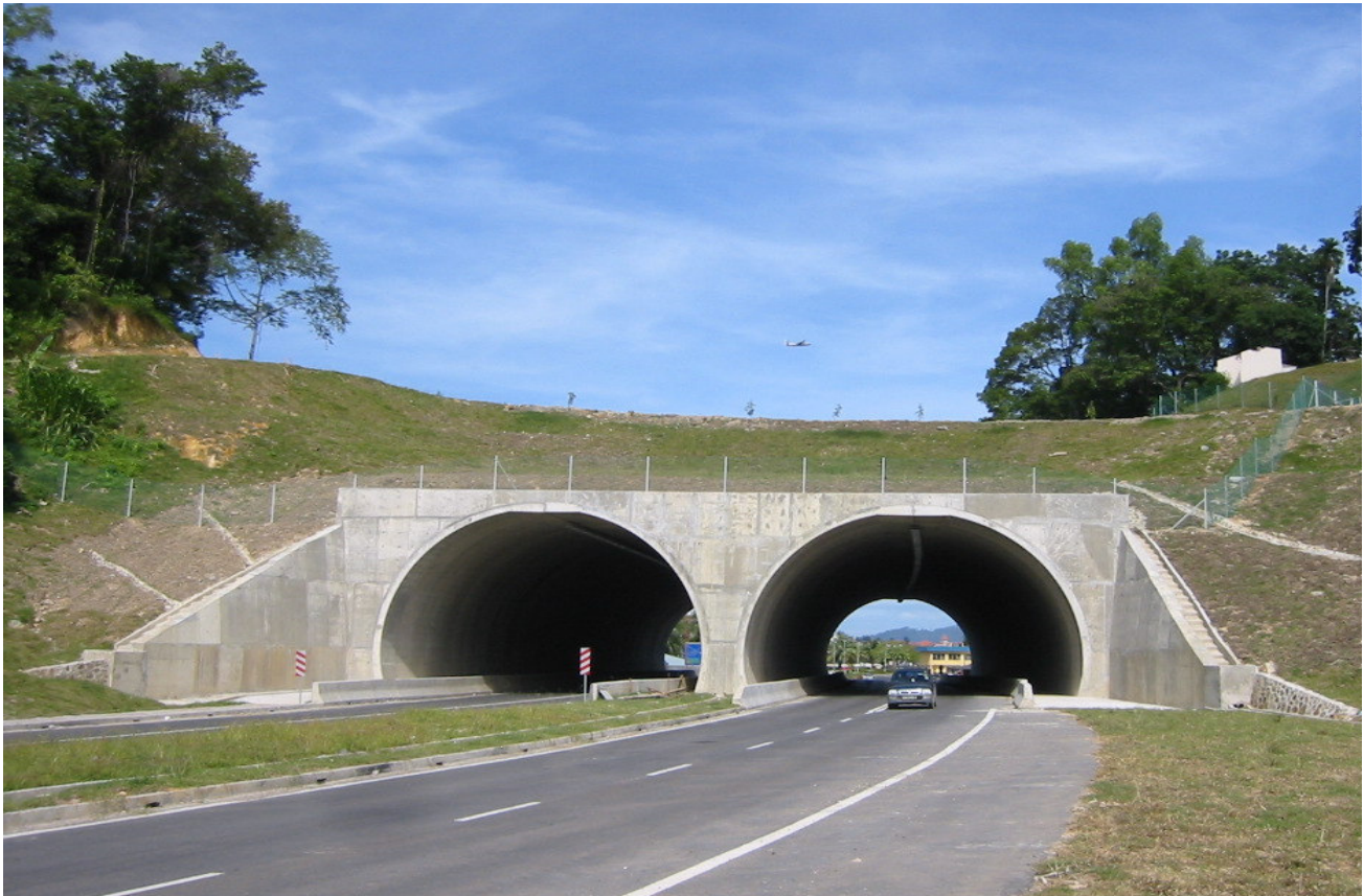
Beton-Fertigteil-Konstruktion mit bis zu 8m Überschüttung (Bemessung bis 12m). Element-Dicke: 300 mm
