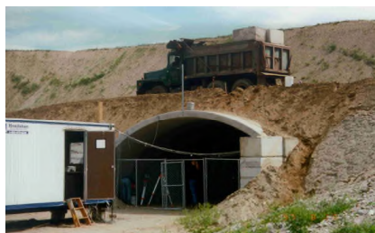
Essai à l'échelle 1:1 aux Etats Unis, dans le cadre du programme d'essais pour les passages sous-voies remblayés. (Massachusetts, 1997).
