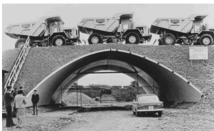
Le prototype BEBO de 160 mm d'épaisseur prouve la capacité portante extrême des ouvrages BEBO (Zurich 1966).
