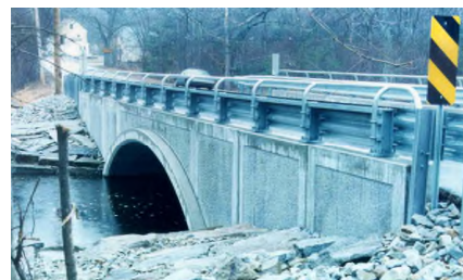
Stoney Brook - Une application typique de BEBO pour les ponts.
