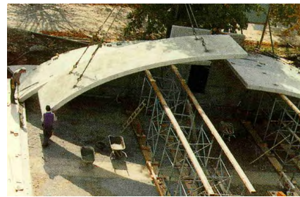
Parking souterrain BEBO sans appuis, pendant le montage (Allemagne).
