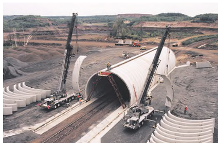
Tunnel BEBO en éléments préfabriqués pour remblai haut et véhicules de mine de 500 tonnes (Etats Unis).
