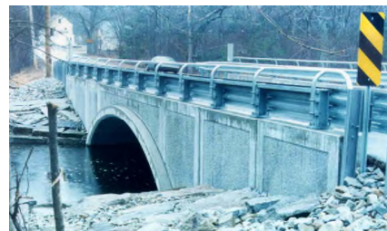
Stoney Brook – Eine typische Anwendung von BEBO im Brückenbau.
