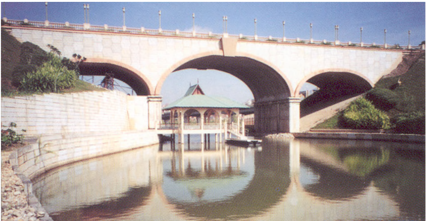
Die weitest gespannte überschüttete Fertigteil-Bogenbrücke der Welt – 25 m mittlere BEBO Spannweite in Putrajaya, Malaysia.
