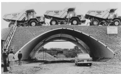
Der 160 mm schlanke BEBO-Prototyp beweist die extreme Tragfähigkeit der BEBO-Bauwerke (Zürich 1965).
