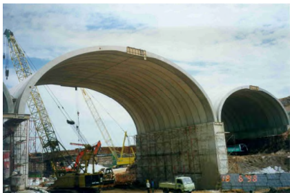
BEBO Typ E84T: Weltgrösste überschüttete Fertigteil-Bogenbrücke in Putrajaya, Malaysia.
